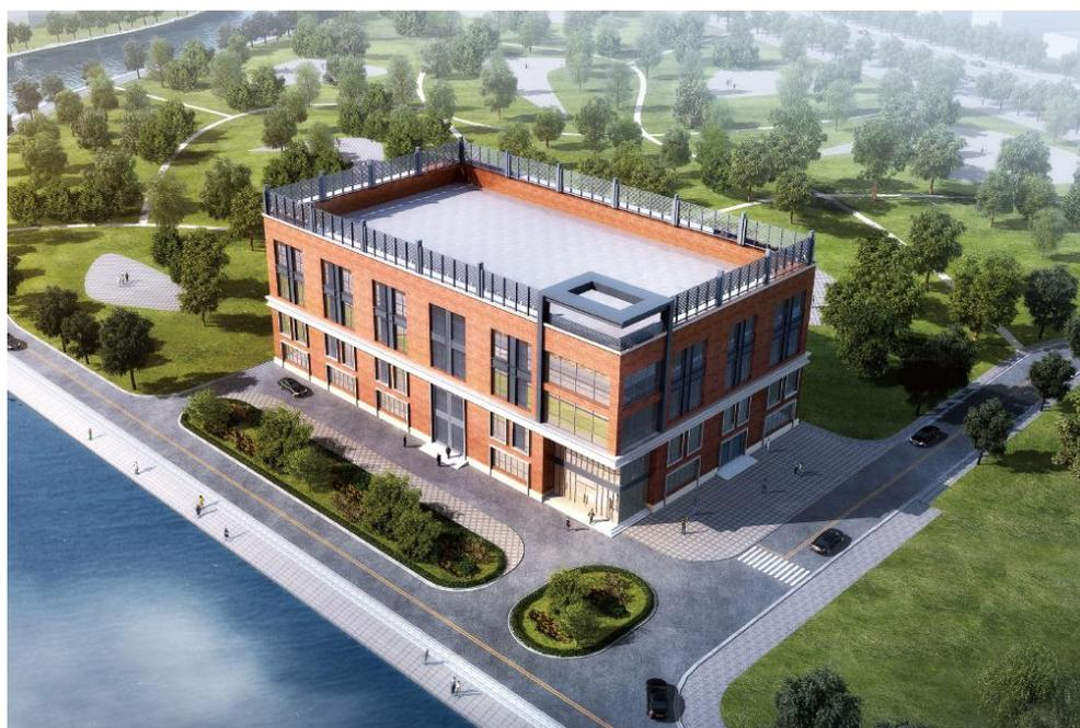
图 3-23 部分地上+部分地下的能源站效果图
