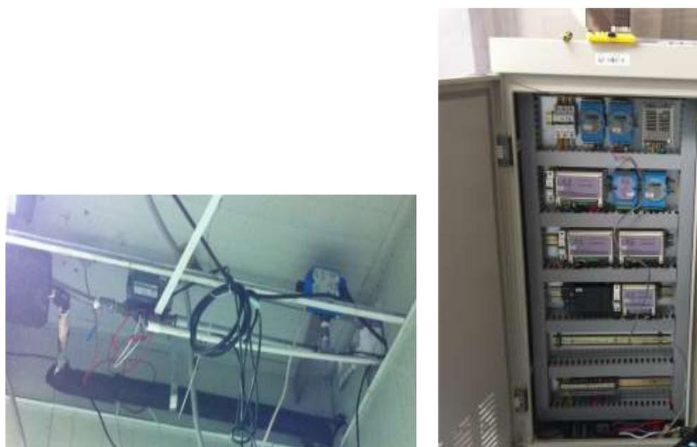
图 59 冷热量计以及三通阀（左），控制柜
